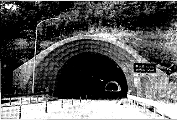
사진 18. 시고쿠 중관 자동차도로 우라노이께터널 갭문
