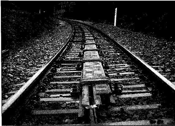
사진 13. 레일빔 설치
