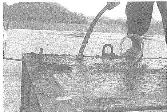
(사진 5) 콘크리트의 진동다짐
