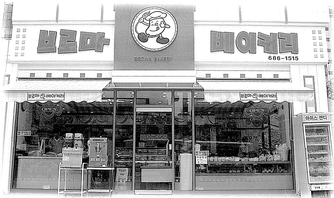
외장전경. 슬러시 기계와 아이스크림을 점두에 배치해 여름철 고객을 유인하는 효과를 거두고 있다.
