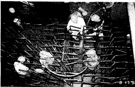
〈사진-5〉 광안대로 현수교의 앵커블록 저판 콘크리트 타설장면
