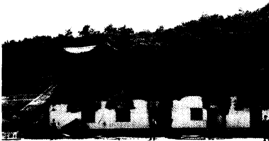
사진 1. 컨테이너 프레임 및 벽체는 화재시 변형이나 강도상실을 막기 위한 내화조치가 전무한 상태였음.
