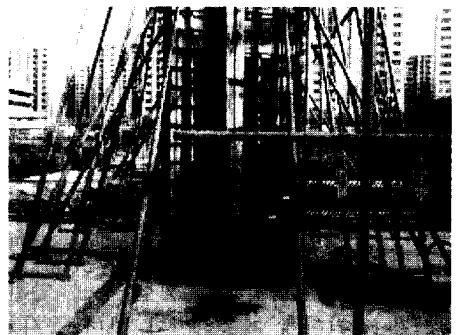
사진 1 기둥거푸집 설치 사진
