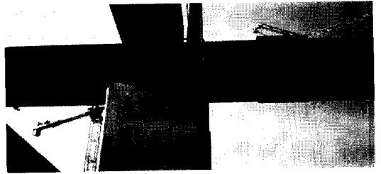
그림 2 철근콘크리트 기둥-강재보를 사용하는 공법
