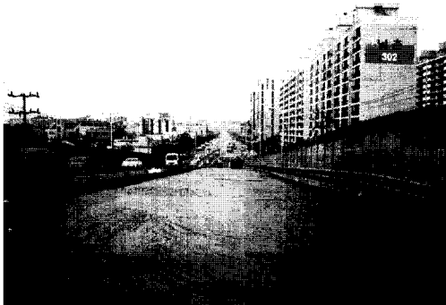
사진 8 상부콘크리트 교면방수 시공후
