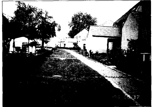
그림 2. 주택가에 설치된 저지수로(swale)모습
