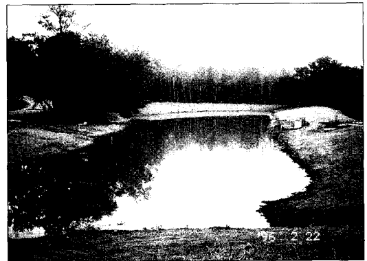
그림 3. 홍수저감과 수질관리를 위한 습식저류지 (미국 플로리다 텔라하시 소재)
