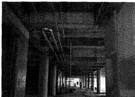
〈사진 4〉 배관설치 전경
