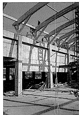
동안교회 글루램 공사현장
