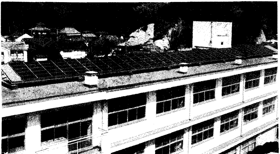
그림 8. 옥상에 설치된 태양광 발전설비
