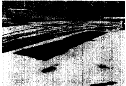
그림 4 아스팔트 포장 전면용설방식에 의한 시공예
