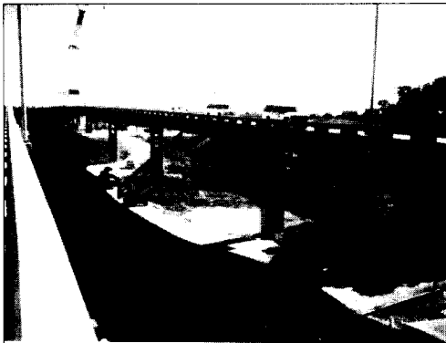
사진 1 San Angelo교량 전경
