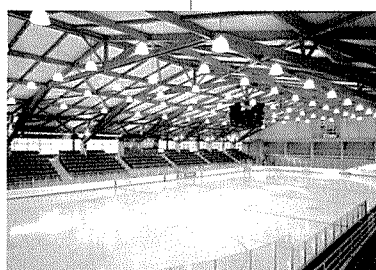
Ice Rink와 목재 Truss로 시공한 Canada의 South Surrey 체육회관내 전경 (정말로 잘 어울리는 경제적 구조물이다)
