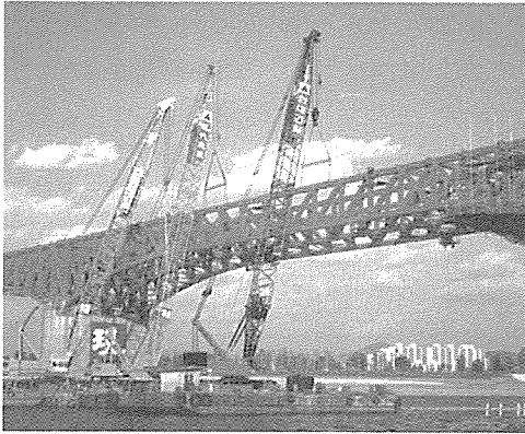
사진 5. SUSPENDED TRUSS 설치
