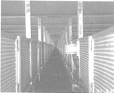
사진 7. TRUSS 하부 점검통로 설치
