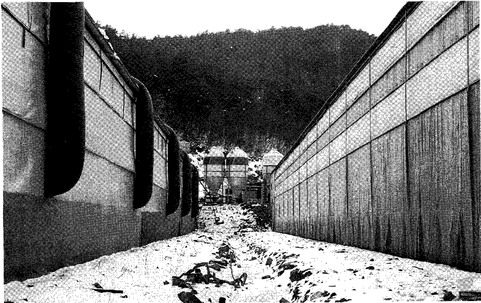
△환기에 도움을 주는 환기통 설치 (좌)와 미설치 (우)농장
