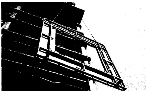
〈사진 1〉 유니트 패널 설치
