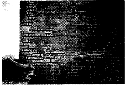
사진 25 시공상의 결함에 의한 균열
