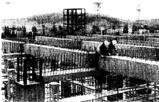
그림 12 Step 2 : PC Post & Grille beam
