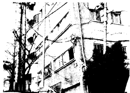
사진 1 고베시 Nada 지역의 피로티 형식의 구조물 파괴양상
