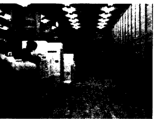
〈사진14〉수장고 내부의 나무는 스피스 또는 너도밤나무를 많이 사용하며, 못을 쓰지 않는다. 나무벽은 콘크리트 옹벽에서 최소 60cm 이상 띄운다. 수장고 내부는 수납할 수 있는 가구가 다양하게 있어야 하며, 분류, 배치 작업이 이루어지므로 조명에 유의하여야 한다. 또한 바닥은 목재로 마감하여 유물을 떨어뜨렸을 때 손상을 최소화 시켜야 한다.
