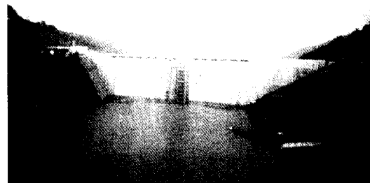
그림 5. 상류에서 바라본 미야가세 댐 전경 (중앙에 다단식 취수탑이 댐 본체에 부착되어 공사중인 것을 볼수 있다.)
