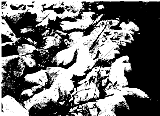
그림 5. 양재천 과천 시험구간 시공(촬영: 1997. 6)
