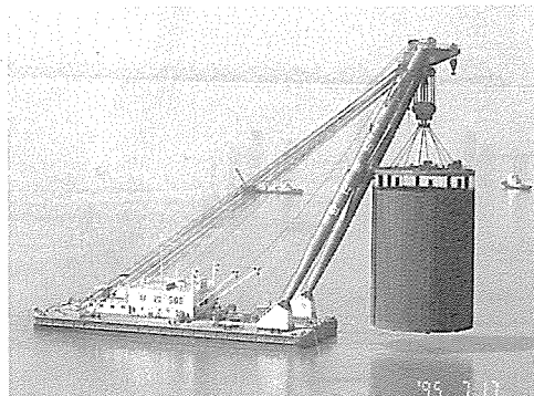
설치 위치로 운반중인 Cell
