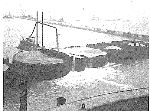
속채움 모래 시공
