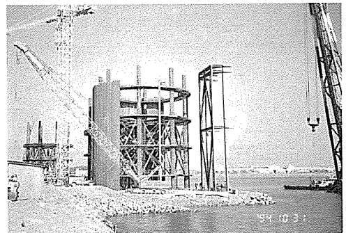
Template와 SH'T Pile 조립 광경
