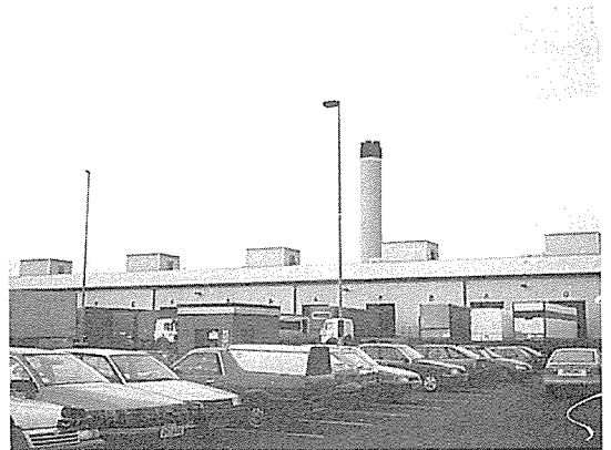
(사진 1) 영국의 Elm Energy사. 5개 소각로마다 폐타이어 반입구가 있음.
