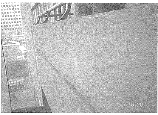
〈사진 11〉 열화방지층을 위한 방청페이스트의 전면도포
