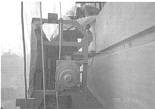
〈사진 3〉 콘크리트 표면의 들뜸부위의 제거
