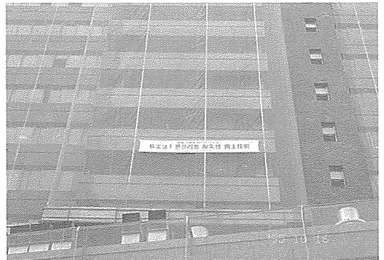
(사진 1) 시험시공 전경(쌍용양회 본사 7층)
