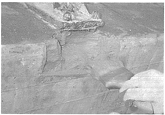
〈사진 9〉 RF방청페이스트를 사용한 방청처리
