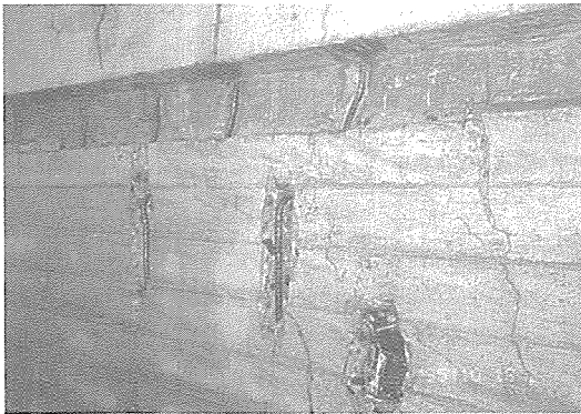
〈사진 6〉 고압수를 이용한 구조체 표면의 이물질 제거작업 종료상황
