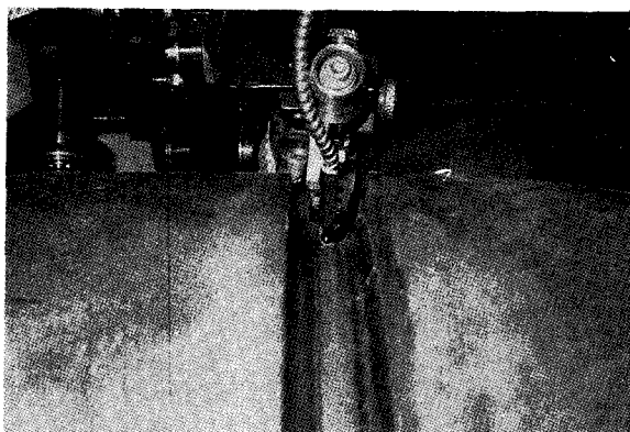
원자력 배관 SUS PIPE HOR. 용접
