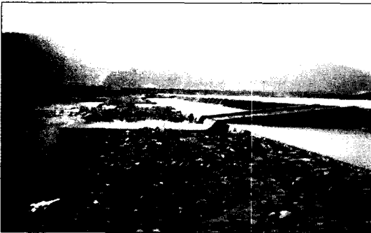
<그림 2> 강릉 연곡면 연곡천에 설치된 도벽식 어도
