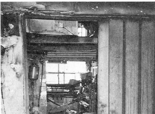
<사진 5> 화재 후 내부의 모습 - 벽체 상부만이 일부 그을렸으며, 전체적으로 피해가 거의 없었다.
