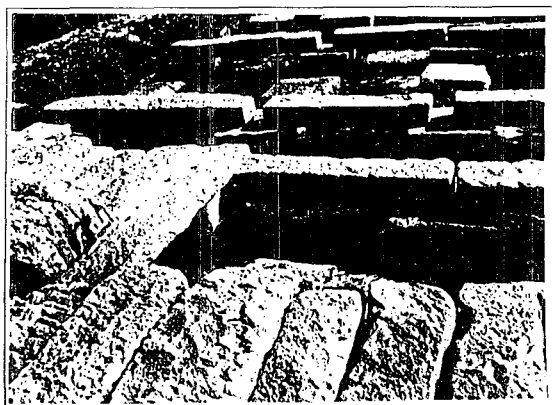
사진 4. 감은사 금당지의 바닥구조(자료: 필자 사진)
