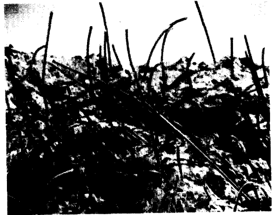
그림 4 강섬유보강 콘크리트의 파괴면
