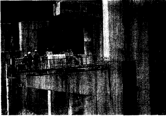
사진 9 Diamond Wire Saw에 의한 교각 절단모습
