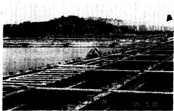
사진 7 임의 지간의 전슬래브가 인양된 후의 모습
