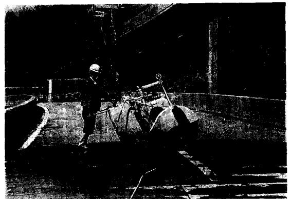
사진 8 Diamond Wheel Saw에 의한 슬래브 절단모습
