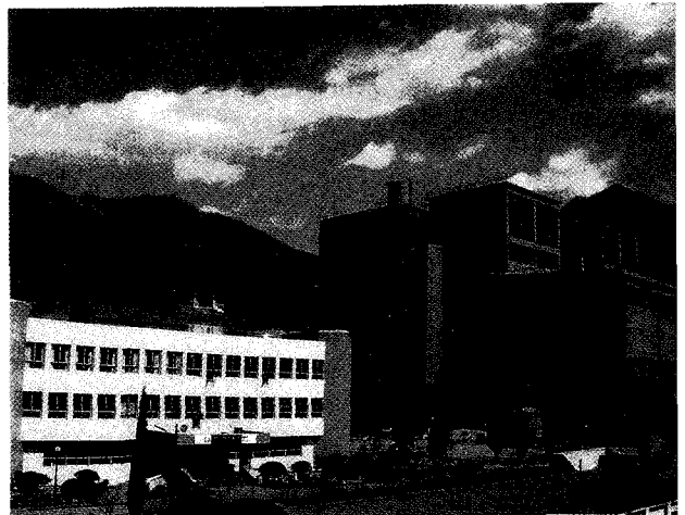
영월 화력 발전소 전경
