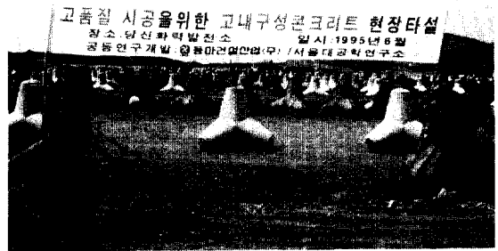
그림 1 고내구성 콘크리트 현장 1차 시험 시공 전경 (당진 화력발전소 Tetrapod 현장)
