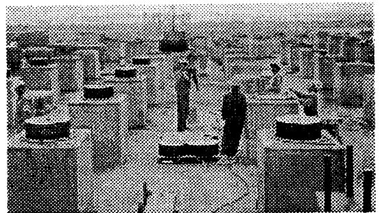
그림 12 LRB의 구조 및 설치사진
