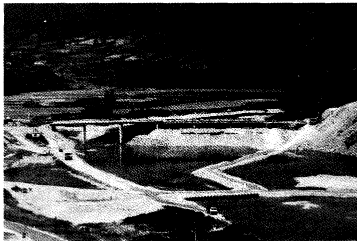
사진 2. 하류 교량 시공 광경
