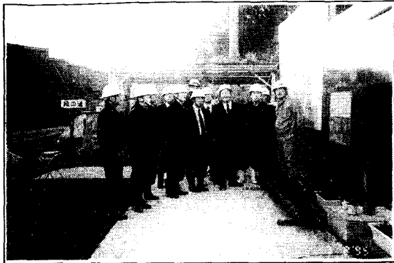
横浜長浜 Tunnel(海林建設)
