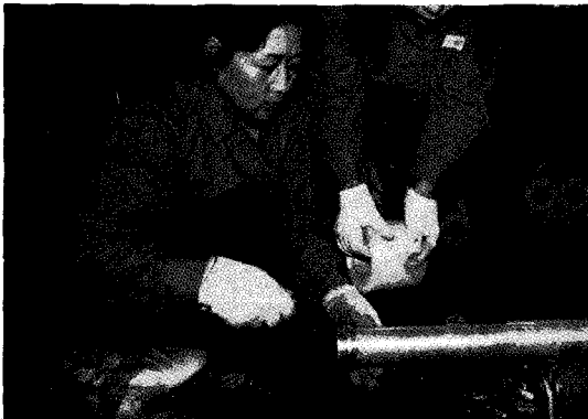
롤러 위에 파이프를 놓고 파이프를 돌려가면서 비닐을 감는다.
