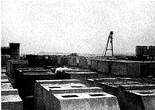
〈사진-4〉 케이슨과 콘크리트 블럭을 제작중인 모습.
