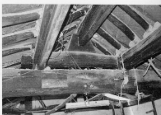
Photo 2. 대량의 부식부위를 파내고 신재로 보수한 상태(김주태 가옥)
