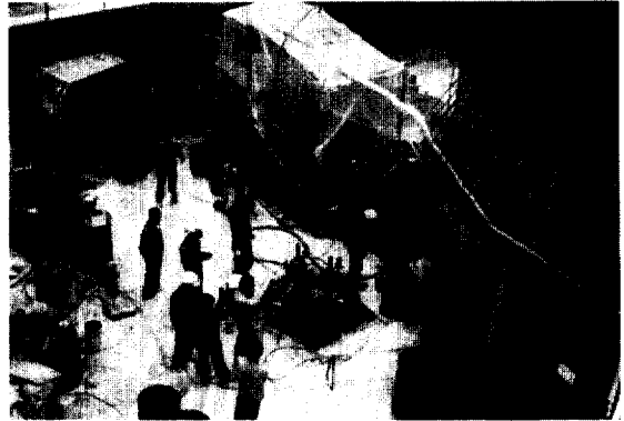
사진 3 grout 주입장면
