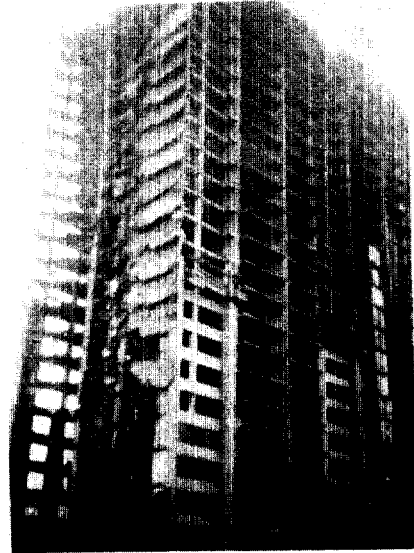
그림 2 거푸집 조기제거로 인한 skyline plaza tower의 붕괴 (Kaminetzky (15) )
