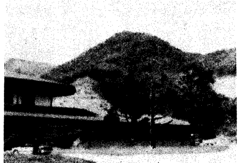
(그림 2) 진입로에서 본 클럽하우스 전경(시공 후)
