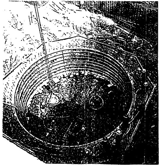
Fig. 4. Fore Shaft 시공.
