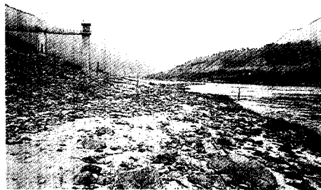
〈사진〉 상류 좌안에서 본 송정 수위관측소(1992-11-5 KICT 촬영). 1917년 5월부터 관측이 개시되어 현재도 운영되고 있는 섬진강을 대표하는 관측소이다. 유역면적은 4255.7km 2 , 하폭은 약230m, 하상은 사진에 보이는 것처럼 모래와 자갈이 섞여 있다. 이 관측소에는 유량관측을 위한 cableway가 설치되어 있다. 하상이 낮아져서 관측소를 강안쪽으로 1차 연장을 하였으나 다시 연장을 해야 할 것으로 보인다.
