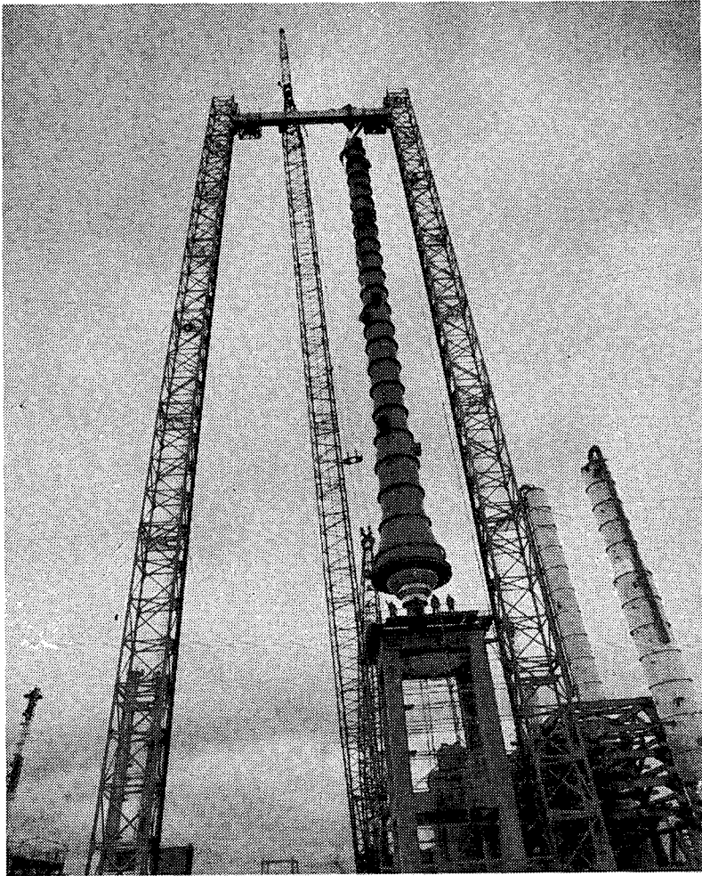
重量物 設置 作業 모습
