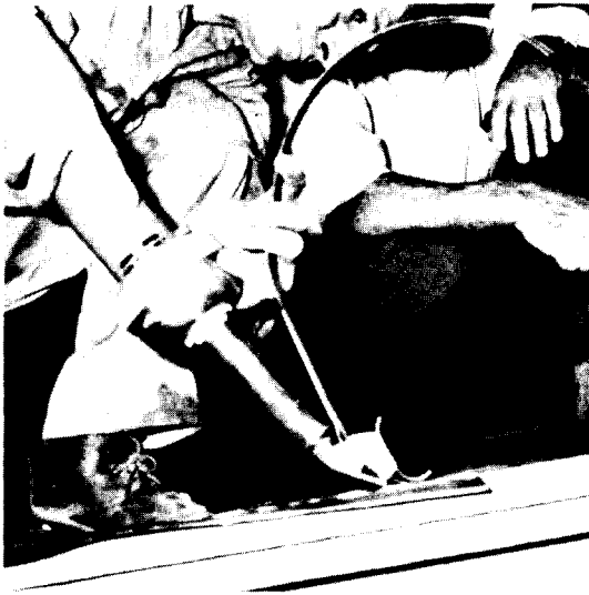
그림 3 열풍 자동 용접기로 "Blanket" 용접 작업 장면
