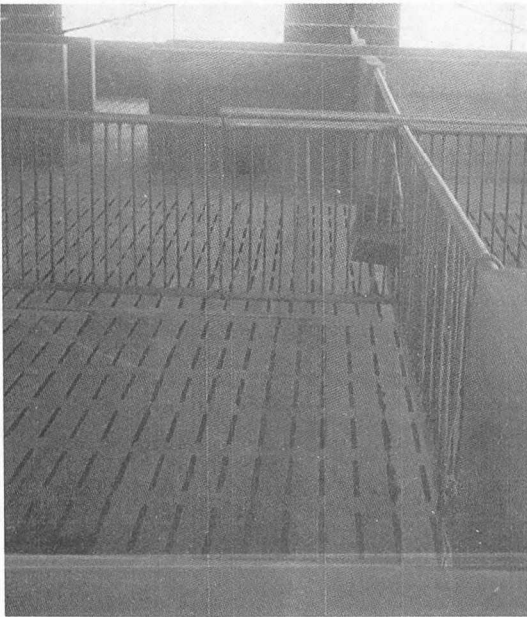
〈바닥망 설치 및 내부공사 완공〉
